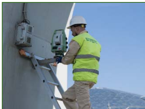
Монтаж системы мониторинга деформаций в парке «Зарядье»
